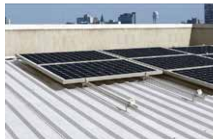
Telepítés ipari tetőre
