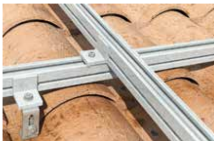
Solar-fish profilok keresztcsatlakozása
