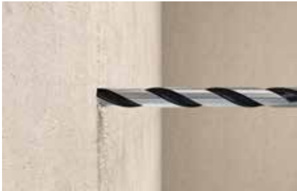
Furatkészítés betonba
