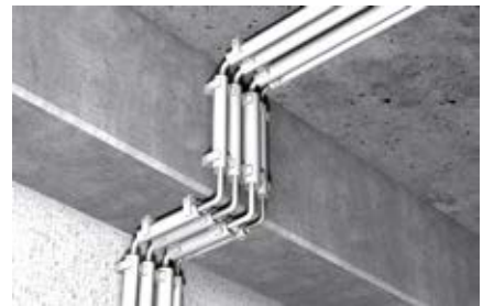
Műanyag szigetelőcsövek rögzítése
