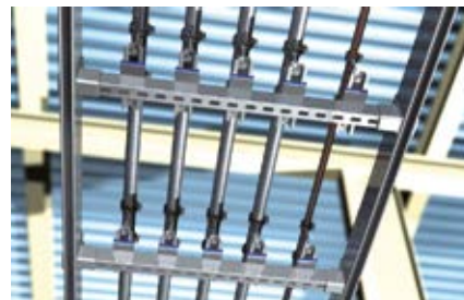
Tolócsúszka függesztett szerelő rendszeren
