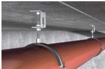
Állítható magasságú csőszerelés
