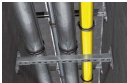
Csőrögzés menekülő útvonalaknál
