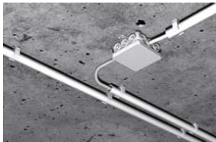
Műanyag szigetelőcsövek rögzítése
