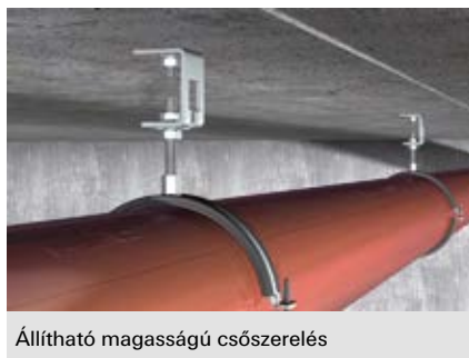
Vízvezetőcső szerelés
