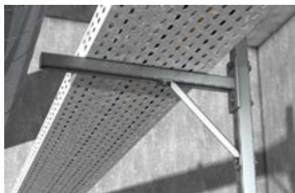
Kábeltálcák rögzítése
