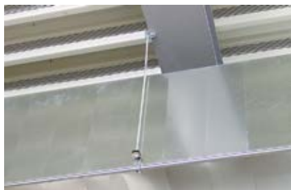
Légcsatorna függesztése acél gerendáról
