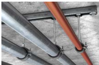
Csörögzítések szerelősínekkel
