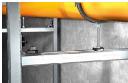
Csővezetékek keretszerkezeteken
