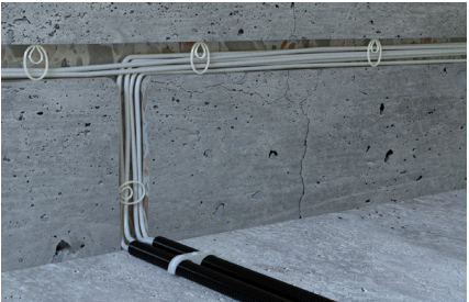
Kábelrögzítés falhoronyba < 55 mm
