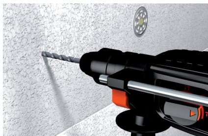
Polisztirol rögzítése téglafalhoz
